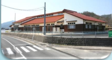
道路からの園舎
